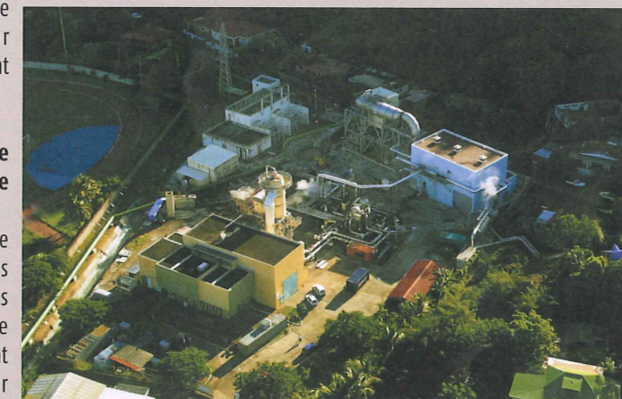
Légende : Centrale géothermique de Bouillante productrice d'électricité.
